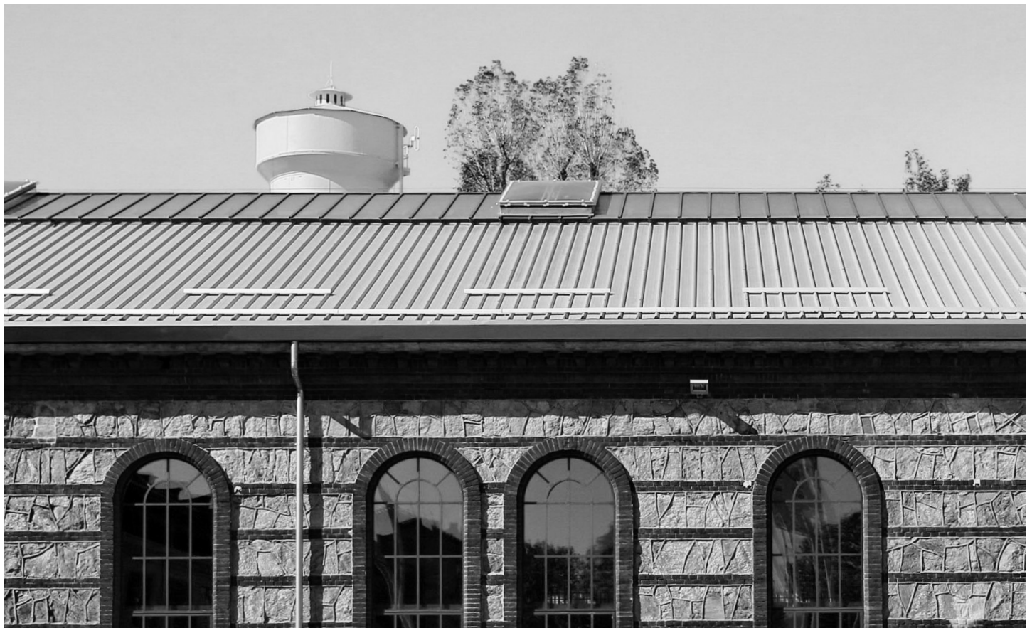
Foto n° 5: copertura realizzata con pannelli sandwich Isolpack Lithos 5 certificati al fuoco.
